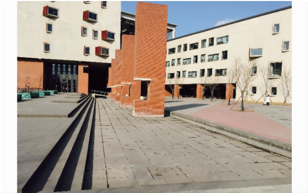
图9 建筑馆区的蓄水池
