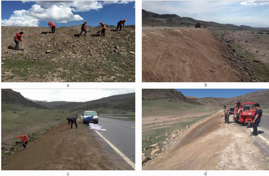
注:a. 试验区清理;b. 试验区覆土;c. 播种供试植物;d. 洒水养护
