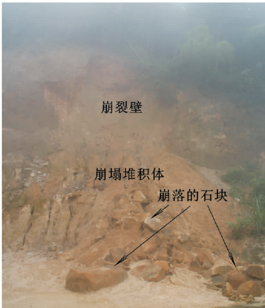
图4 团山村人工切坡崩塌后的边坡
