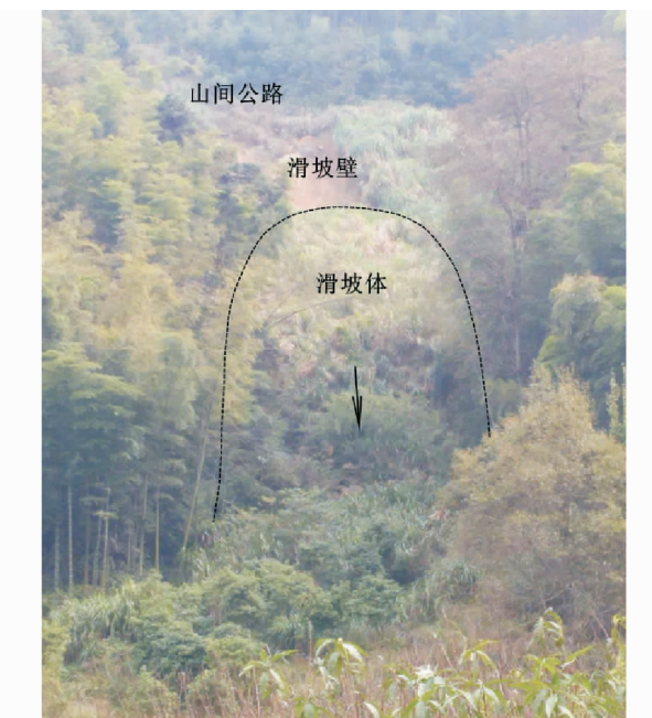
图3 团山村公路下侧的滑坡
